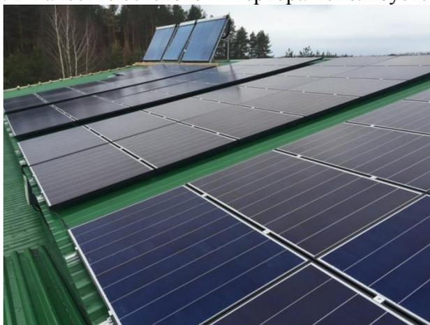
Рисунок 2 - Сетевая солнечная электростанция на 20 кВт от компании АЛЪТЭКО
